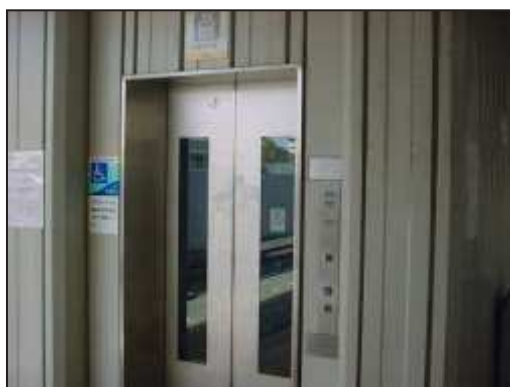
堺東駅バリアフリー化（エレベーター）
