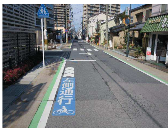
細街路に自転車の左側通行を明示している例（守山市）
