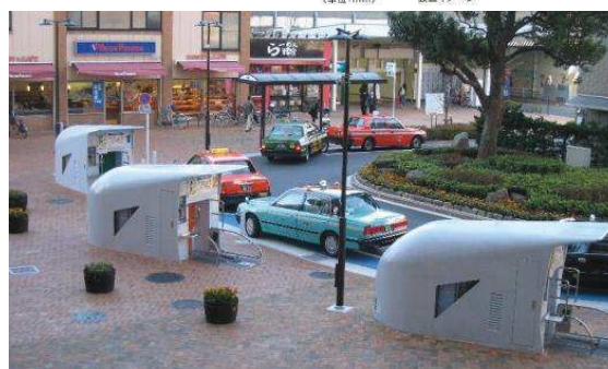
機械式地下駐輪場の例（江戸川区）
